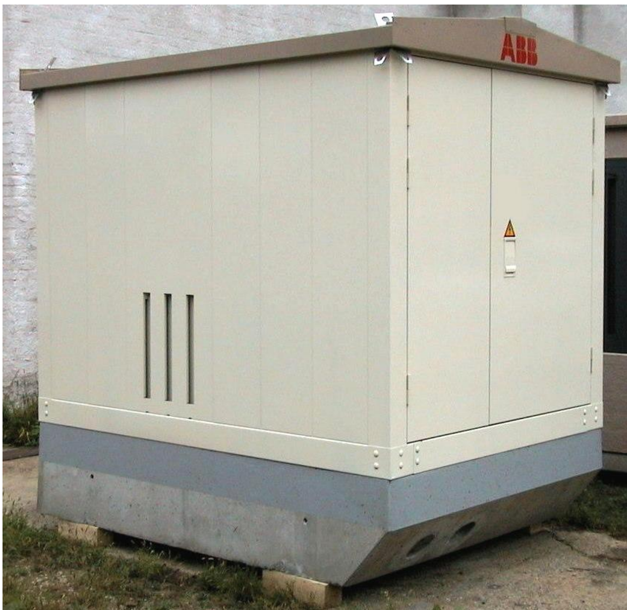
ABB Merkur 630 típusú lemezházas kompakt transzformátorállomás
